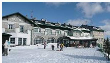
Gsolhirn - Bergstation der Raxseilbahn mit Gasthof
