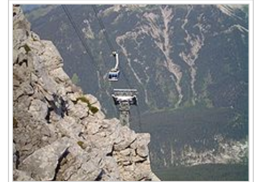
Blick auf die Stütze II der Tiroler Zugspitzbahn in der Nähe der Wiener-Neustädter-Hütte
