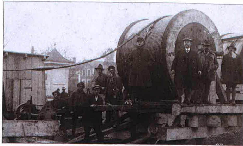
Bis heute hängt die nostalgische Predigtstuhlbahn auf dem originalen Trageseil aus dem Jahr 1928. Alle 12 Jahre wird das Seil um sechs Meter verschoben. Reserven sind noch für 36 derartige Manöver vorhanden. Die Ankunft des Seiles wurde gebührend in Szene gesetzt, allein der Seilzug war eine sehr gewagte Angelegenheit. Fotos: Predigtstuhlbahn
