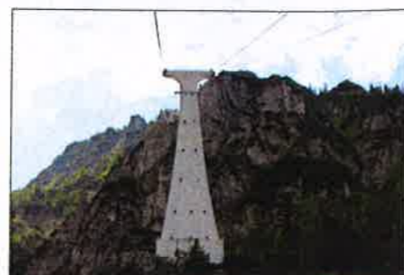
Betonstützen, die höchste 32 Meter hoch, bieten „tonnenweise Verlässlichkeit“.
