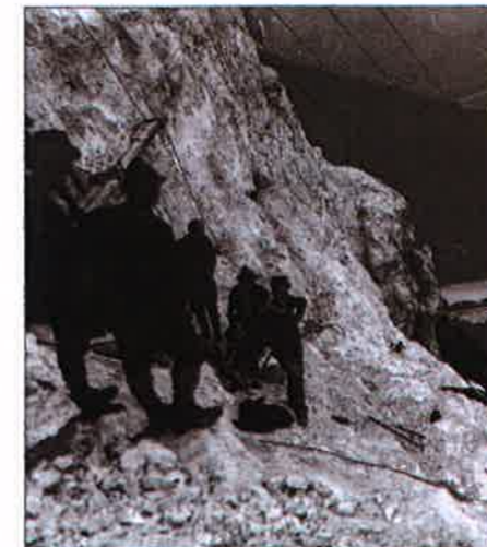
Alles reine „Handarbeit“ – und dennoch während der Bauzeit völlig unfallfrei.
