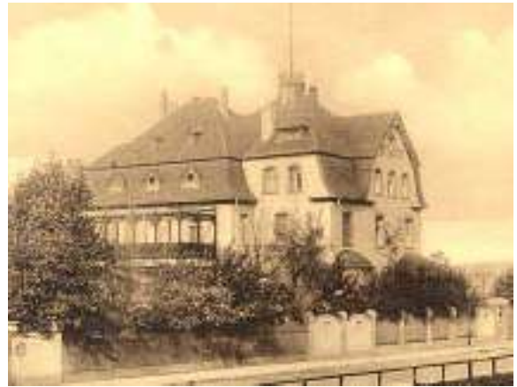
Villa Kleiststraße 11 , erbaut 1908 Wohnsitz Paul v. Bleicherts als Villa Berthe bis 1922, 2003/4 Sanierung durch LWB u. Verkauf als Eigentumswohnung
