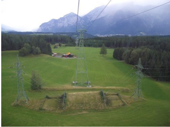
Kreuzung Patscherkofelbahn mit Bahnstromleitung
