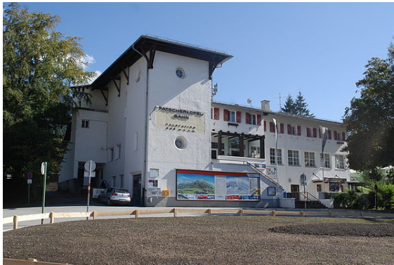
Talstation der Patscherkofelbahn
