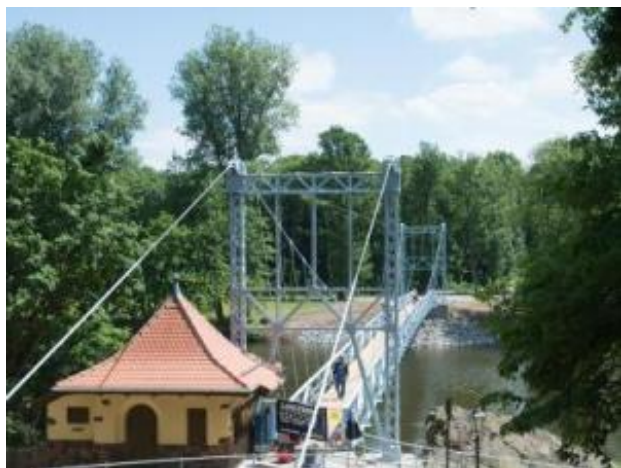
(Ansicht von Wärterhäuschen)
